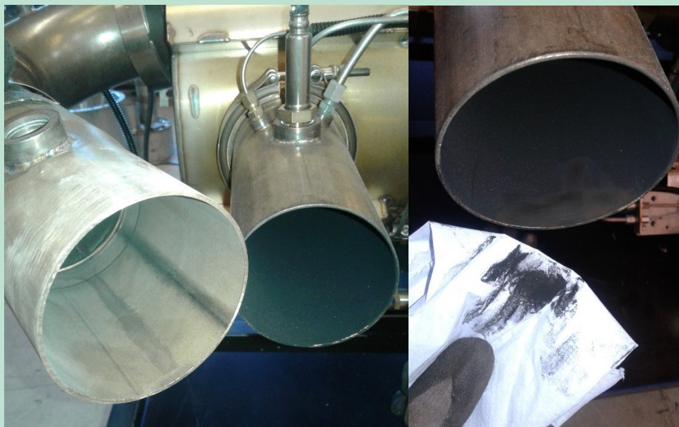
FIGUR 30. Visuel kontrol af ind samt afgangsrør på Purefi emissionssystem
